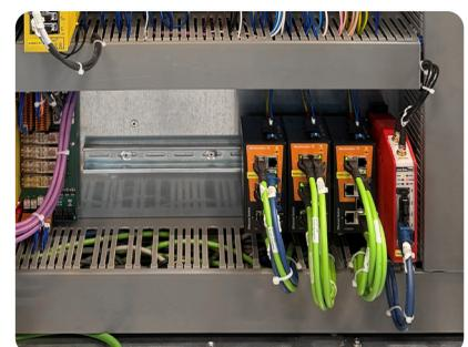
Damit konnte der IPC von der zusätzlichen Rechenleistung entlastet und zugleich die Trennung zwischen Maschinen- und Kundennetzwerk über die integrierte **Firewall- und Routingfunktionen** der IRF sichergestellt werden.
